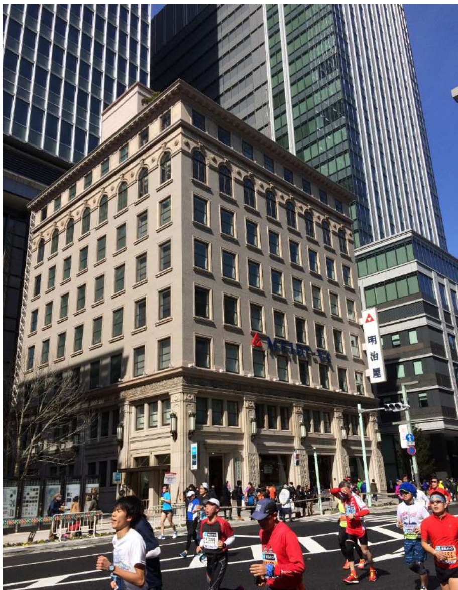
保存1933完工的明治屋(中央區指定有形文化財)
